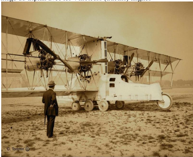
Octobre 1915 remontage du triplan avec les 4 moteurs (tractifs) alignés
