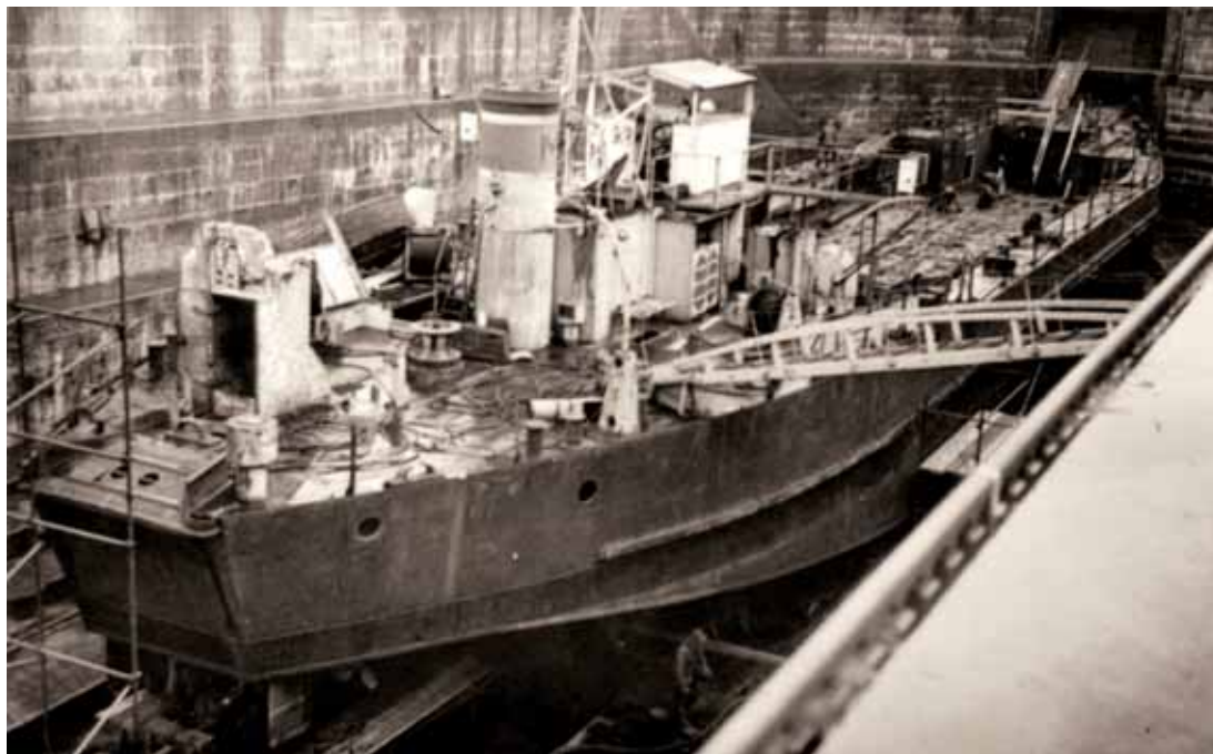
Le Salvor vu également en cale sèche ne semble pas avoir été photographié à Marseille, ni à Toulon, ni à Cherbourg. Nous ne connaissons ni le lieu, ni la date de la prise de cette photo. On note toutefois le grand désordre sur le pont en pleins travaux, et la lettre M sur la cheminée. (Collection Maurice Lanlard/Yvon Perchoc)
