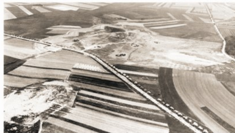
L'ouvrage du Saertrich vu d'avion lors de son achèvement en mai 1936. Le tracé des réseaux en redans est bien visible, les tourelles d'artillerie aussi. Franchissant la route de Luxembourg, on aperçoit le champ de rails antichars.
