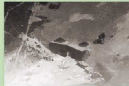
Le bloc d'entrée des munitions vu d'avion à son achèvement en septembre 1934. De nombreux équipements, probablement de ventilation, sont visibles sur le terre-plein. Collection M. Thomann
