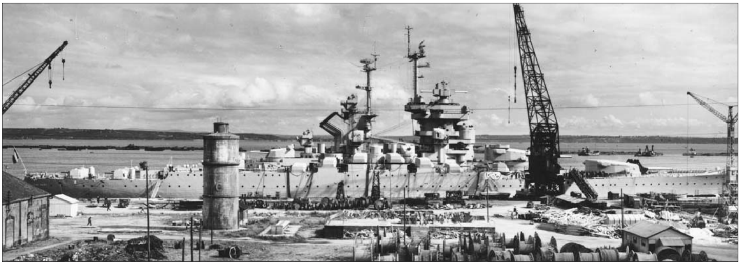
Le Jean Bart amarré à Brest. L'ensemble des tourelles de 100 mm et de 57 mm est maintenant en place, mais les encorbellements pour 20 mm installés sur la tourelle II n'ont pas encore été démontés. (DR)
