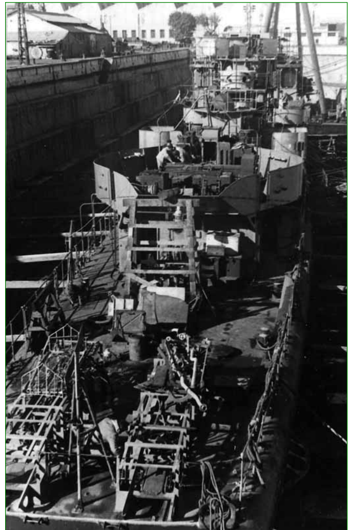
On remarque sur la plage arrière les deux grenadeurs de sillage, les mortiers Thornicroft ainsi que les parcs à grenades ont été débarqués.
